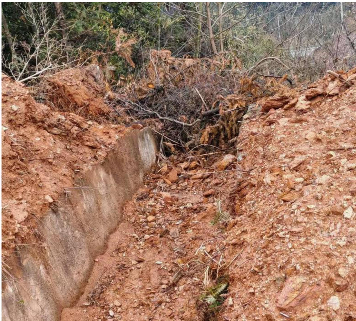
图 2.6-3 溢洪道现状图
